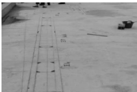
Instalação de posicionamento da base
