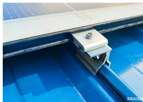
Instalar abrazaderas de borde
