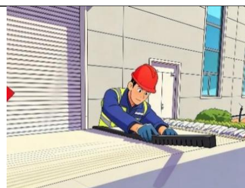
Coloque tiras superiores de EVA en los módulos, un espacio sostiene dos módulos por tira de EVA
