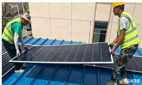
Manejar y colocar los módulos en las ranuras centrales de la abrazadera
