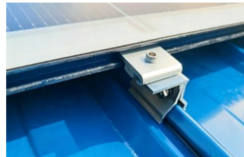
Kantenklemmen installieren
