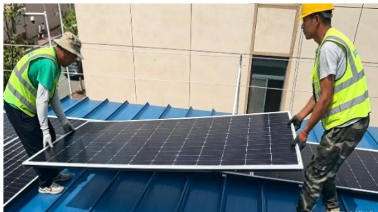
Handhaben und Module in mittlere Klemmschlitz einsetzen
